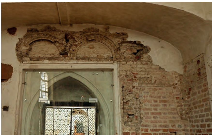
Уваход у капліцу святога Фларыяна (выгляд з боку капліцы). Касцёл святых Францішка і Бэрнарда. Вільня. Рэстаўрацыя 2007—2019 гг. Спроба расчысткі тынкоўкі да аўтэнтычнай цэглы XVII ст. Фота Костаса Шукевічуса.
