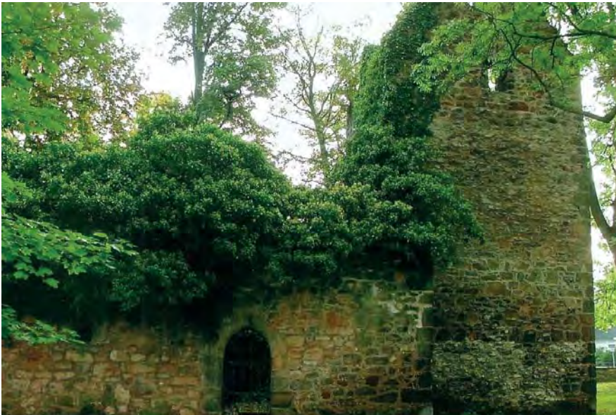
Руіны Фёпштэцкай царквы ў Зальцгітэры-Бадзе.
